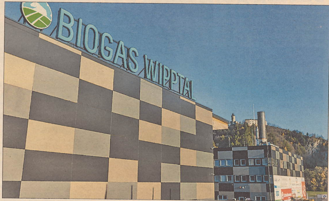
Bis Frühsommer 2021 sollen die umfangreichen Umrüstungsarbeiten an der Anlage in Pfitsch beendet sein.
