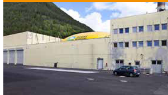
Links ist die Anlieferung zu sehen. In der Mitte befindet sich der Fermenter. Er ist 36 Meter lang und fasst 3.000 Kubikmeter. Im rechten Gebäudeteil sind das BHKW, die Steuerung sowie der Pumpen- und Elektroraum untergebracht.
